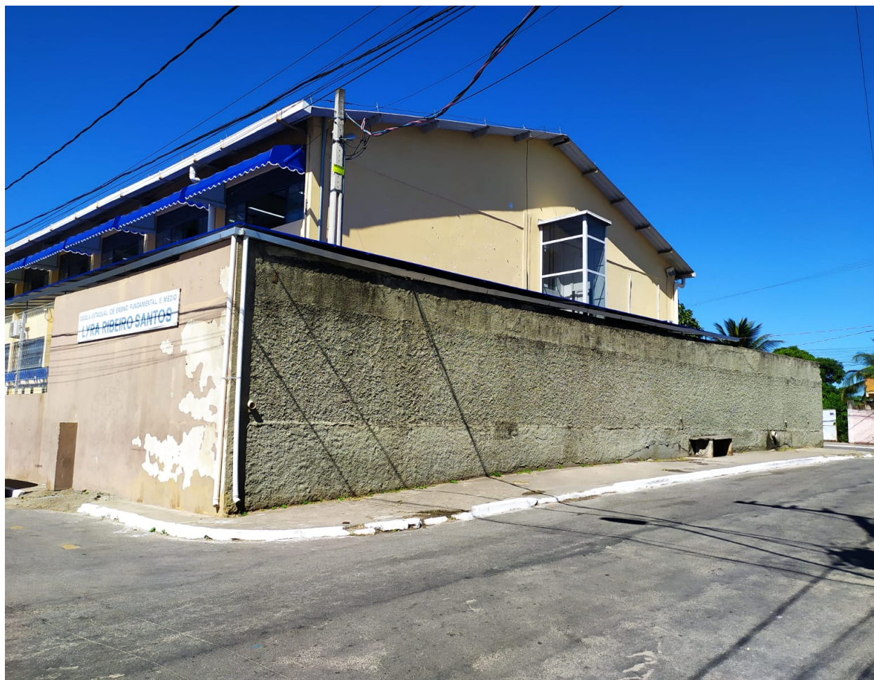
Foto 1 – Vista da plataforma elevatória na lateral direita da unidade escolar
