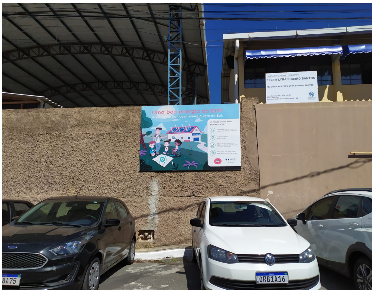
Foto 2 – Vista parcial da fachada frontal da unidade escolar mostrando o espaço restrito entre estrutura da quadra e prédio escolar
